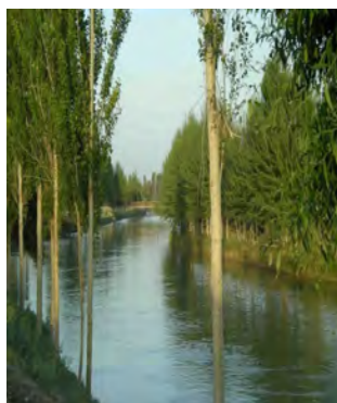
Рис. 1. Фото Большого Ферганского канала[2]
